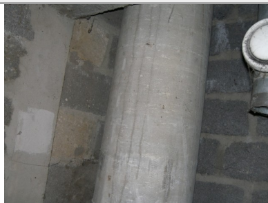
Conduit en amiante ciment
